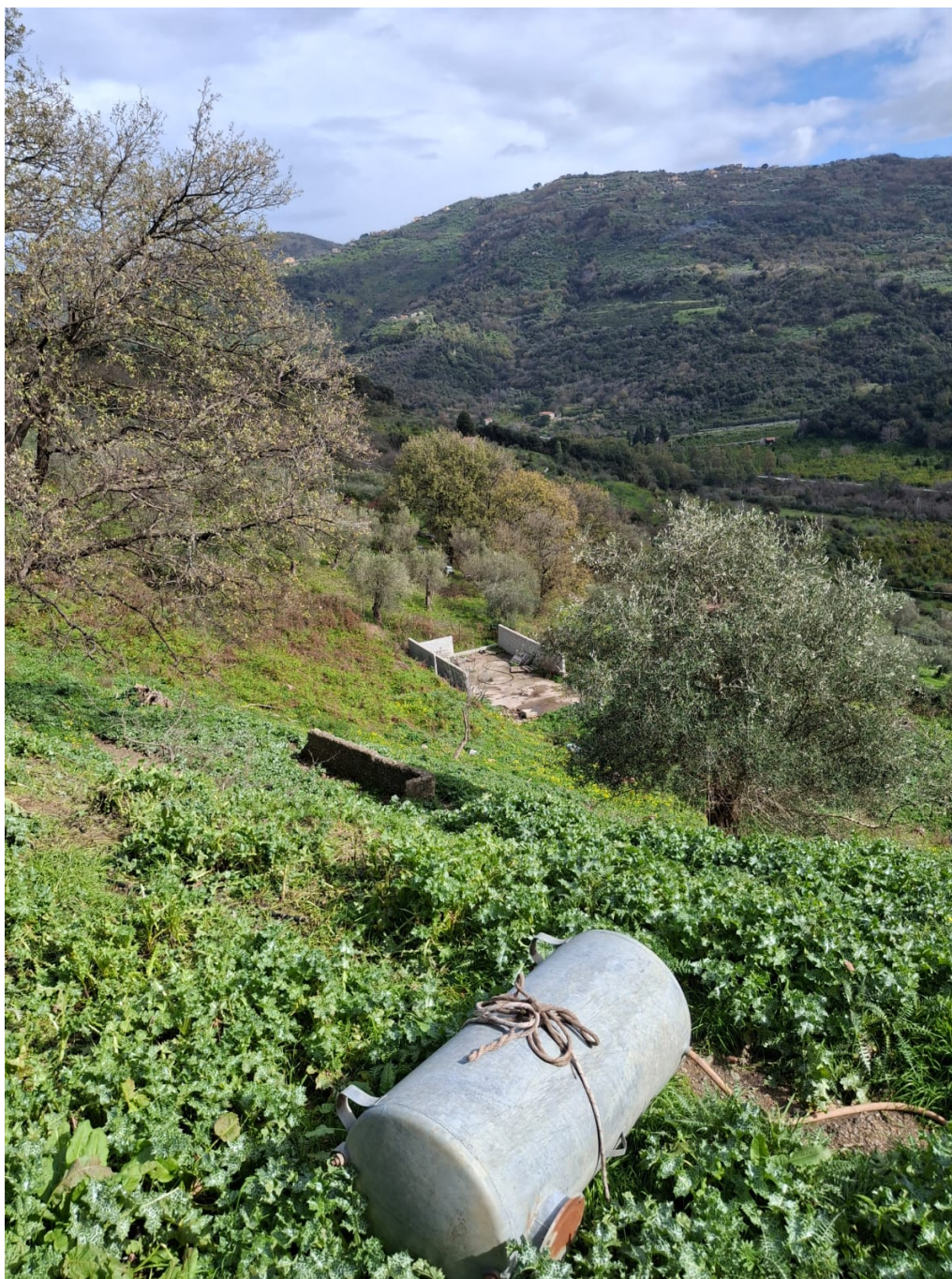
FOTO 03 - PARTICOLARE DI TRACCE DEL DIRUTO FABBRICATO RURALE
